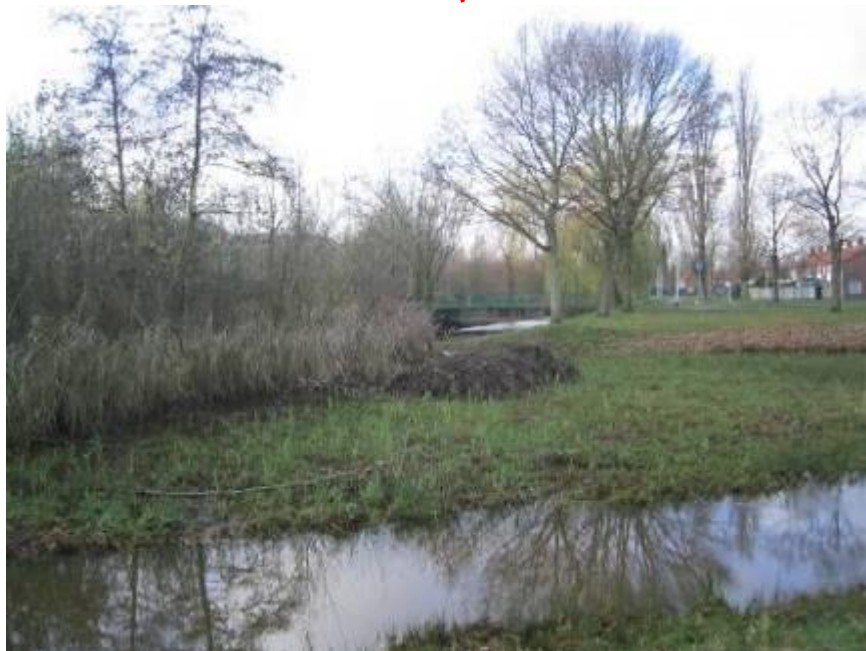
Brug ter hoogte van Nieuwe inslag. Locatie 10.
