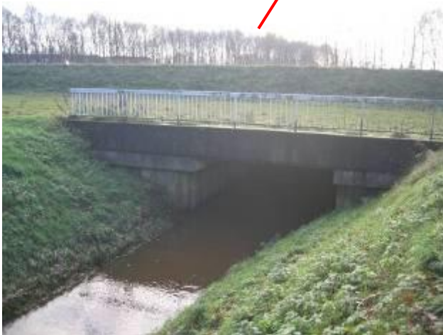
Onderdoorgang Graaf Engelbertlaan. Locatie 4
