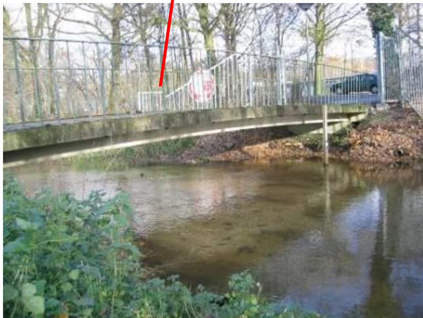
Betonnen brug Charlotte Cuijpersdreef naar de Jeu de Boules baan. Locatie 13.
