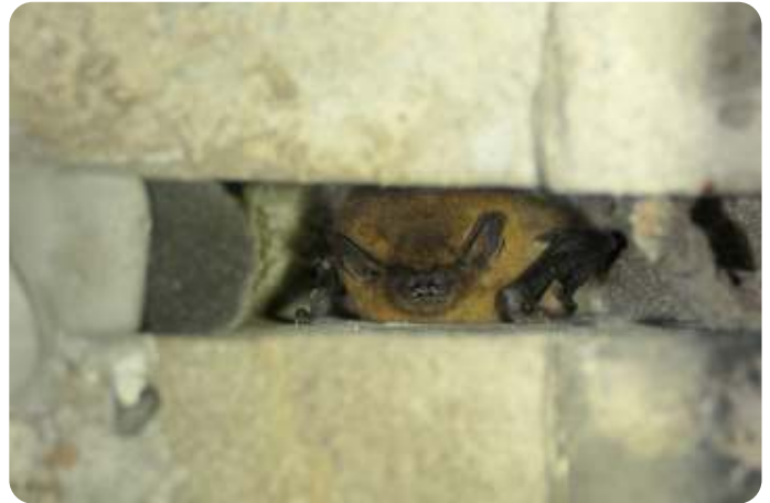
foto: Erik Korsten, gewone dwergvleermuis in dillatatievoeg
